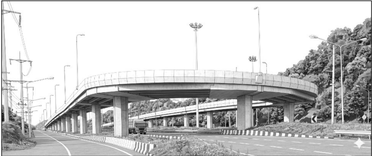
รูปที่ 7.5-1 สะพานกลับรถต่างระดับ (เกือกม้า)
